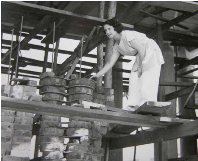
Le Mercure en construction
